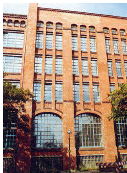
Bild 2: Toni Technik Baustoffprüfsysteme GmbH in Berlin
